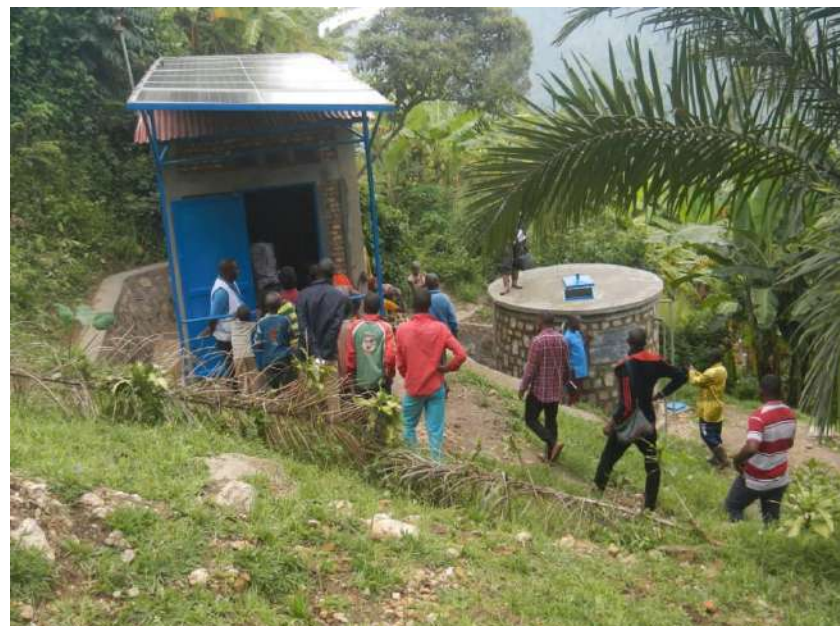
Province de Bubanza , Commune Bubanza , AEP ZINA par Pompage construit en 2024 .Cette AEP dessert le centre de santé de ZINA qui depuis plus de 10 n'avait pas accès à l'eau potable. Elle dessert également les ménages des environs du CDS
