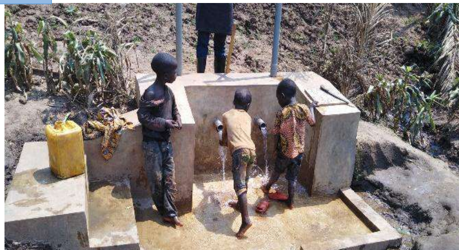
Aménagement d'une source d'eau potable dans la province de Cibitoke
